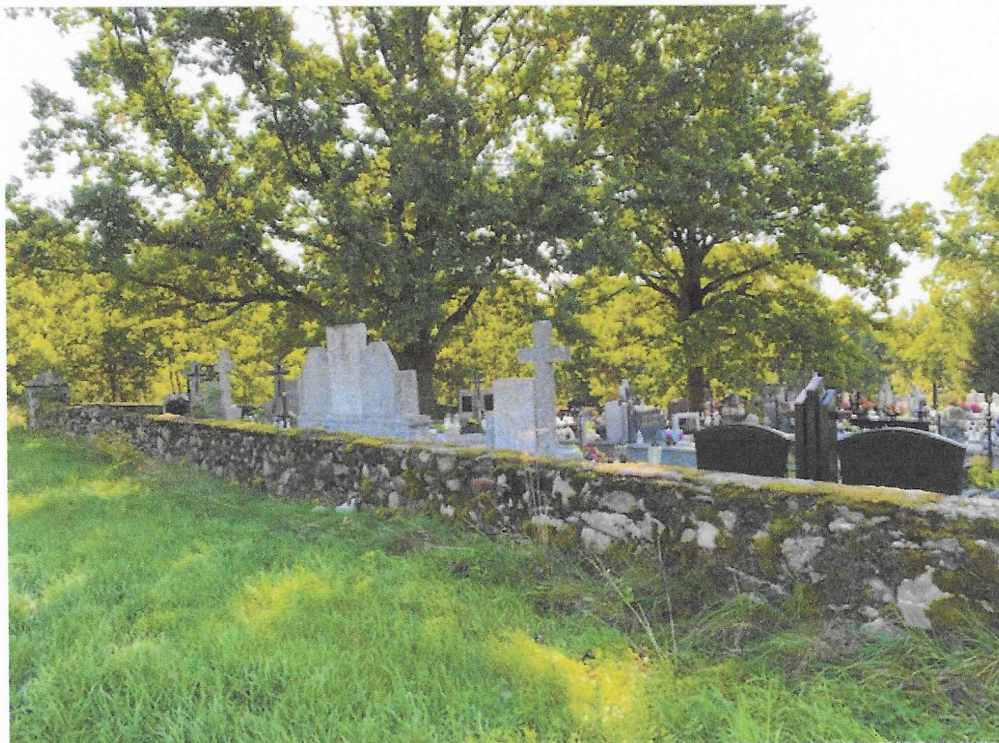
Ubytki w zaprawie cementowej i kamieniu polnym strona wschodnia
